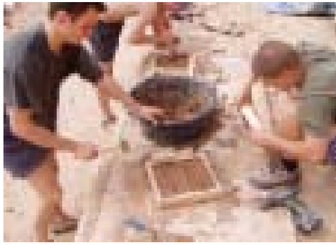
Herstellung der Lehmplatten
